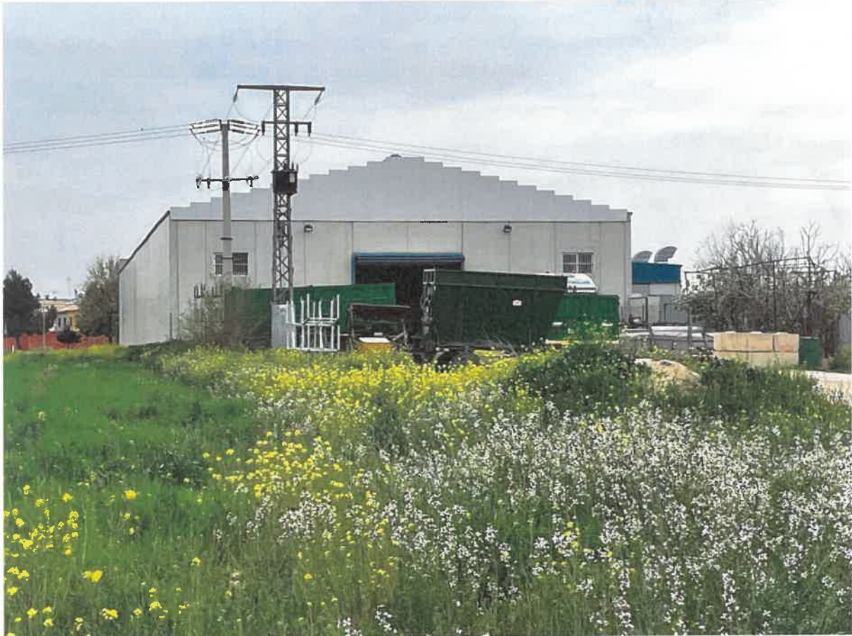
Transformador aéreo ubicado en el interior de la parcela de la empresa AGROBELLÓN.
